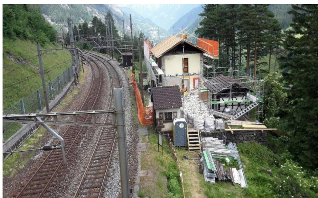
WH Eggwald in Wassen, während Bauarbeiten
